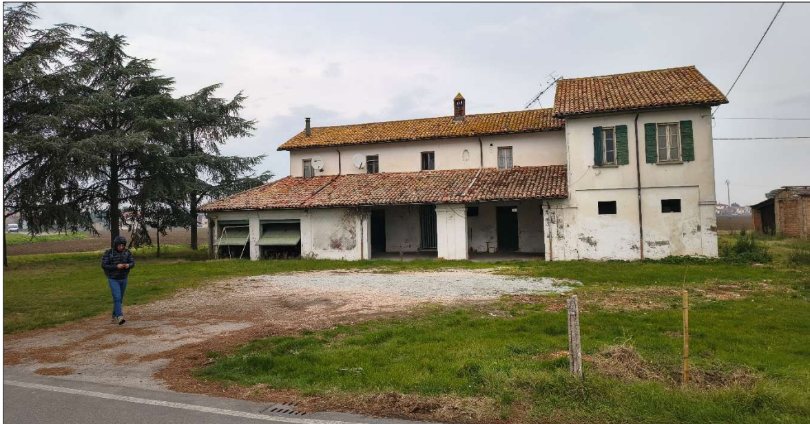
Figura 6-2: fabbricato da espropriare e demolire, al civico 141 di via Renato Medri.
