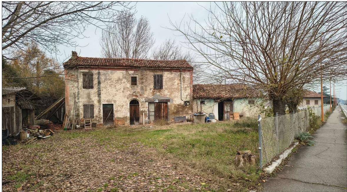
Figura 6-8: fabbricato da espropriare e demolire, al civico 5971 di via Cervese.
