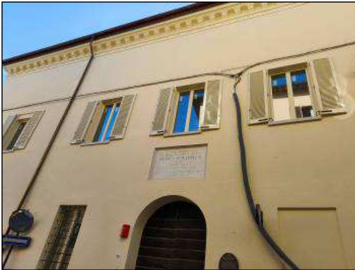
Ingresso via Strinati
